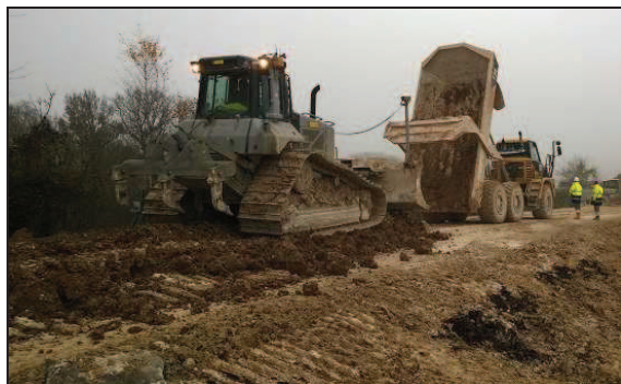
Approvisionnement au tombereau et régalinge au bouteur (à gauche), malaxage (à droite)
