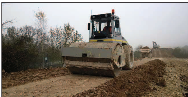
Compactage (passes au V3 bille lisse)
