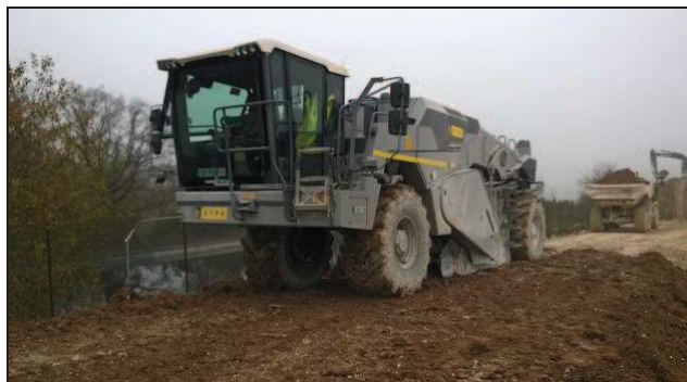
Approvisionnement au tombereau et régalinge au bouteur (à gauche), malaxage (à droite)
